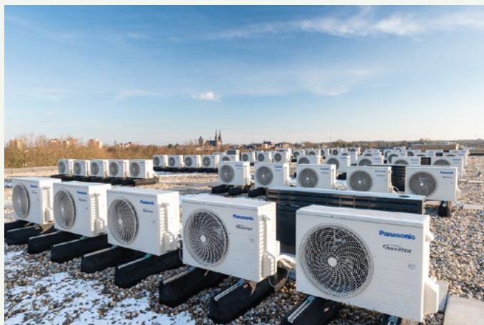
75 Warmtepompen appartementen Cuijk. Aquarea All in One
