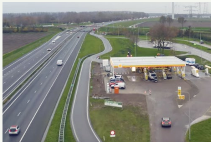
Warmtepomp bij Shell tankstation Buttervliet. ECOi W
